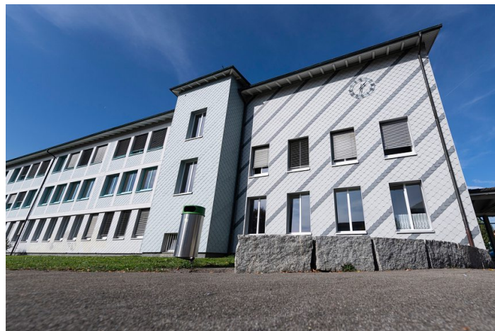
Vor über 50 Jahren wurde beim Bau des Oberstufenschulhauses in der Mühlematt in Belp der Schadstoff Naphthalin in Böden und Wänden verbaut. Fotos: Raphael Moser
