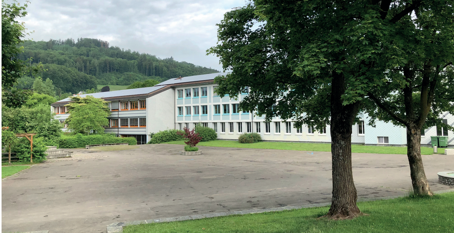
Die Schulanlage «Mühle matt» will die Gemeinde Belp nun doch abbrechen. Fotos: Schär Burri Architekten
