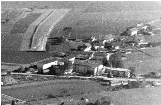
Luftaufnahme aus dem Jahr 1967 während der Erweiterung des Sekundarschulhauses
