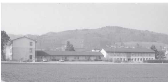
Hauswirtschaftsschule von 1960, mit Abwartswohnung, sowie Primarschulhaus von 1964 Anlage, bestehend aus 3 langgestreckten Putzbauten unter unterschiedlich hohen, schwach geneigten Satteldächern. Nr. 1 von 1960: schlichter Baukörper mit guten, zeittypischen Architekturmerkmalen, z.B. zentraler, NO-seitiger Eingangsbereich mit OG-Rundfenster oder offener Verbindungsgang zum 1951 fertig gestellten Sekundarschulhaus. Quer dazu steht das nachträglich um einen Stock erhöhte Primarschulhaus Nr. 3 von 1964. Dazwischen versetzt eingebaut liegt ein leicht gerundeter Verbindungsstrakt (Nr. 3A), der die räumlich gut gegliederte Schulanlage Müllematt mit ihrem zentralen Schulhof gegen O abschliesst. Die Aussenbereiche werden unter anderem durch 2 für die Zeit um 1960 typische Schulhofbrunnen komplettiert.
