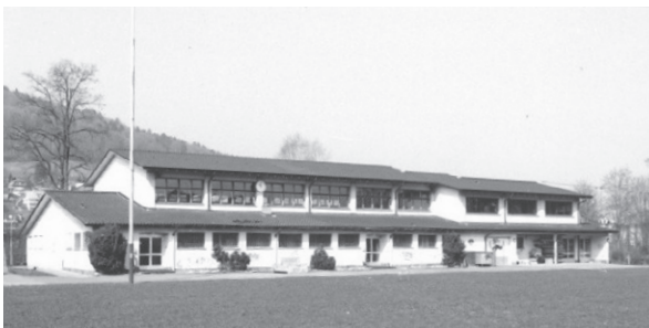
Turnhalle und Werkschule von 1953 Gut strukturierter Putzbau unter abgetropftem Satteldach. Die eigentliche Turnhalle mit hohen, bzw. liegenden Fensterbändern zwischen gemauerten Lisenen ist O- und S-seitig von einem 1-geschossigen Putzdachanbau umgürtet, der alle notwendigen Nebenräume (Umkleidekabinen, Duschen und Geräteräume) umfasst. Mit versetzt angebautem OG schliesst N-seitig der Werktrakt an, der den 1-geschossigen Vorbau z.T. als gedeckten Werkplatz nutzt. Funktionalistisch gedachte Architektur von guter Volumetrie. Wichtiger, langer Baukörper, der die Schulanlage Müllematt mit ihrem zentralen Sport- und Pausenplatz gegen die Gürbe im W abschliesst.
