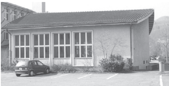
Singsaal von 1965 Eigenwillig geformter Putzbau mit konkaven Schmalseiten. Grosse, 6-teilig gesprossete Fenster (W-seitig erneuert) mit schlichter, die Brüstungszone umfassender Rahmung. N-seitiger Bühnenraum mit separatem Eingang unter Putzdach. Von N nach S ansteigender Satteldach-First und leicht trapezförmig sich öffnender Grundriss als konsequenter Ausdruck akustischer Belange. Zeittypischer, weitgehend original erhaltener Bau. N-seitig an das Sekundarschulhaus angebaut und zusammen mit der Hauswirtschaftsschule (Thalgutstrasse 1) und dem Verbindungsstrakt einen Vorhof bildender Teil der Schulanlage Müllematt.
